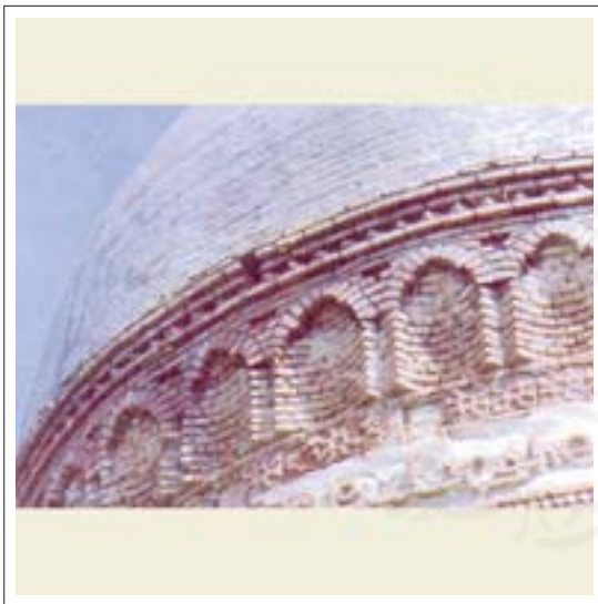
عکس ۵: قسمتی از آجرکاری قطاربندی برج لاجیم
