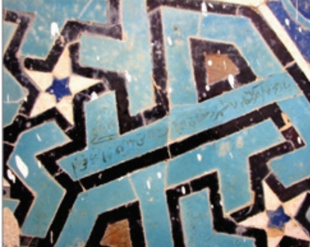
تصویر ۲۴. نوشتن یادگاری بر سطح کاشیکاری منبر و انواع آلودها و چرک‌ها بر سطح آن (عکس از نگارنده).
