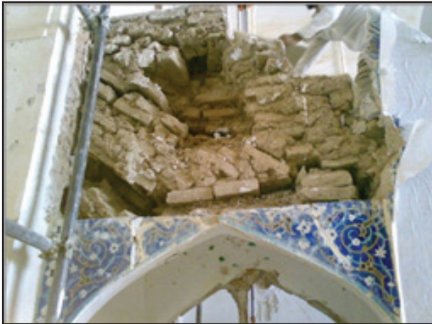
تصویر ۲۷. پوسیدگی و خوردگی کامل چوبهای به کاررفته در سازه (عکس از نگارنده).
