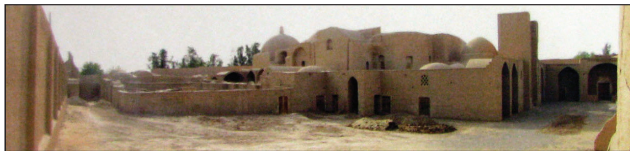
تصویر ۲. نمایی از مجموعه سلطان بندرآباد (مأخذ: طرح مرمت مجموعه سلطان بندرآباد یزد).
