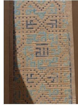
تصویر ۱۲. استفاده از کاشیکاری به شیوه معقلی بر دیوار ضلع جنوبی حسینیه (کوفی بنایی الله/ محمد/ علی) (عکس از نگارنده).
