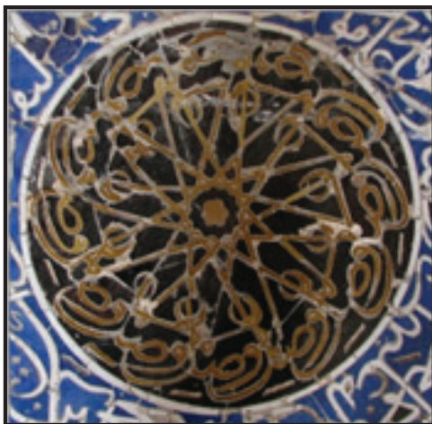
تصویر ۳۵. تراش و بازسازی قطعات آسیبدیده و نصب آن در محل (عکس از: نگارنده).
