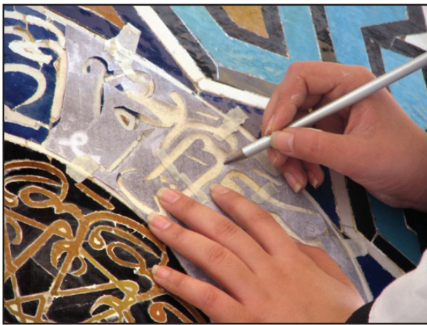
تصویر ۳۹. کشیدن طرح مورد نظر بر روی گچ زبره به عنوان بستر و جانشین لعاب (عکس از: نگارنده).
