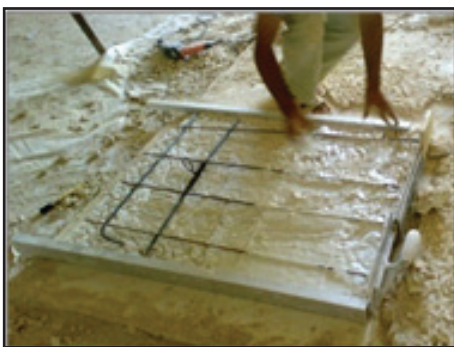
تصویر ۳۱. ریختن دوغاب و سپس ملات گچ در پشت کاشی‌ها (عکس از: نگارنده).
