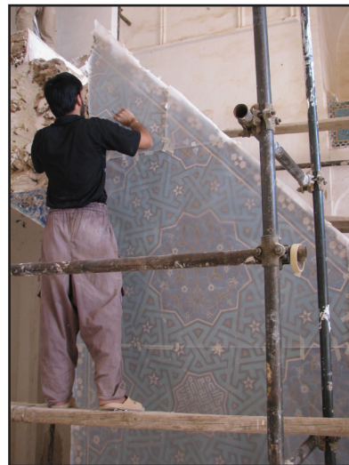
تصویر ۲۸. جدا کردن کامل تاج منبر و انتقال آن برای انجام عملیات مرمت (عکس از: نگارنده).
