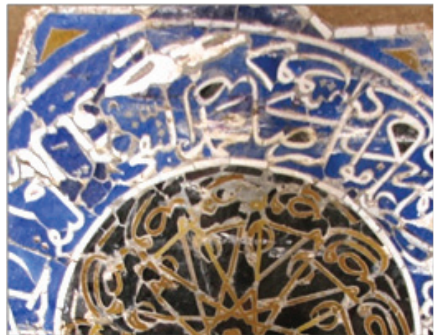
تصویر ۲۳. نمونه‌ای از تعمیرات غلط گذشته روی کتیبه صلوات کبیره (عکس از نگارنده).
