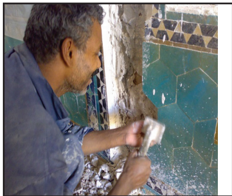
تصویر ۳۳- نصب کاشی‌های بازسازی شده (عکس از: نگارنده).
