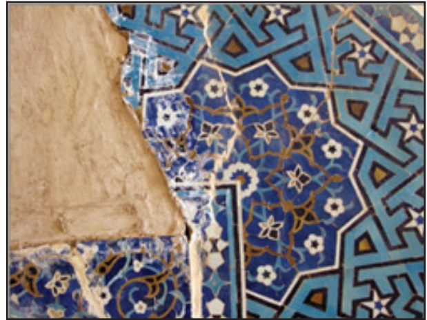
تصویر ۲۵. نمونه ای از ترک‌های عمیق طولی در پایین تاج منبر (عکس از نگارنده).
