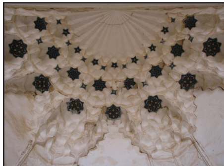
تصویر ۱۱. استفاده از کاشی هایی با نقش ستاره چند پر در مقرنس گچی و پر کار مسجد. (عکس از نگارنده).
