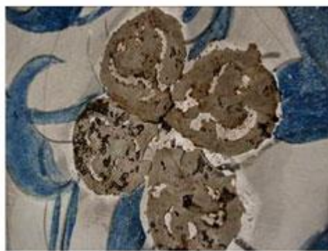
تصویر ۹- آرایه گچی قالبی نوع ج، سقف گنبد بقعه سید رکن‌الدین، تکرار یک نقش و قرارگیری لایه نقش روی هم
