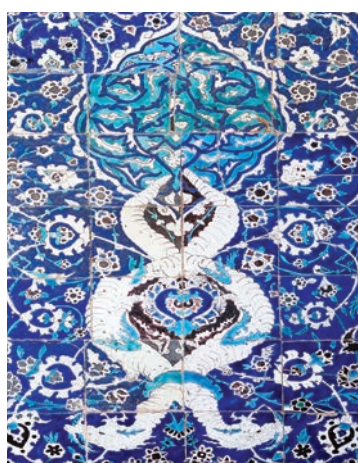
تصویر ۲۰: بخشی از قاب کاشی هفت رنگ صفوی که سرهای اژدها با کاشی جدید و با طرح تغییر یافته جایگزین شده است. مقایسه کنید با تصویر ۲۱، صفه سمت راست ایوان ساعت، صحن عتیق
