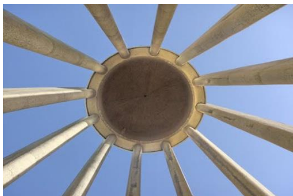
شکل ۳. پره‌های دوازده‌گانه برج بر روی بام به منظور کاهش تأثیر بادهای نسبتاً شدید همدان از یکدیگر فاصله گرفتند و با عبور از سقف به داخل فضای اصلی مقبره ادامه یافته و بر روی یک دایره اطراف مزار را از محیط پیرامون جدا می‌کند ( www.flickr.com )
