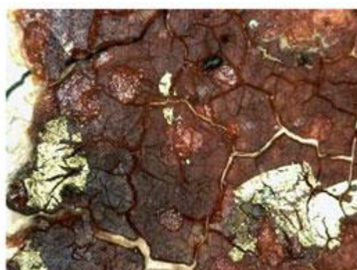
تصویر ۱۸- چسبیدن ورق طلا بوسیله روغنی که با گل ارمنی (گل سرخ) رنگی شده است، قسمت شمشه مرکزی سقف گنبد
