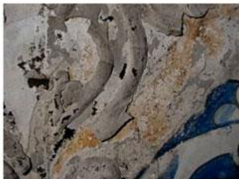
تصویر ۱۰- آرایه گچی قالبی نوع ج، سقف گنبد بقعه سید رکن الدین، ریختگی لایه تزئینی و نمایان شدن چسب زیر آن
