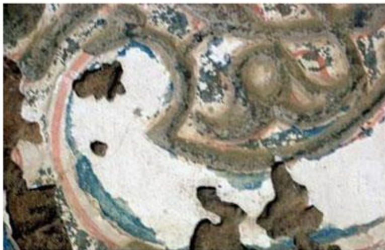
تصویر ۱۲- ریختگی تزئینات گچی فتیله ای در برخی قسمت ها و نمایان شدن رنگ قرمز
